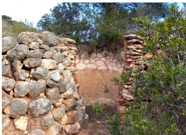
Detall de l'argila en el mur interior del forn.
