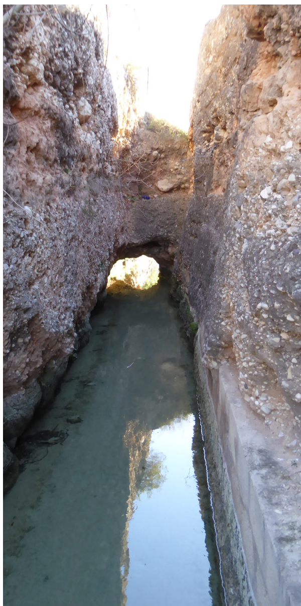
Mina Sèquia Particular Barranc de les Coves
