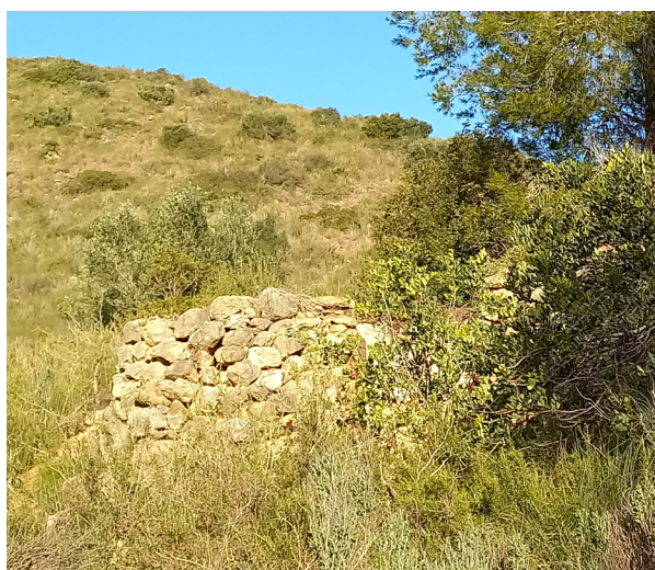
La situació del forn de calç Perspectiva del forn de calç de Sento Frígols.
