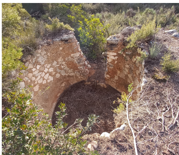
El forn de calç de Sento Frígols. Detall de la porta d'entrada del forn, per on s'introduïa la llenya per a la combustió.
