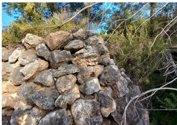
Mur exterior del forn de calç.
